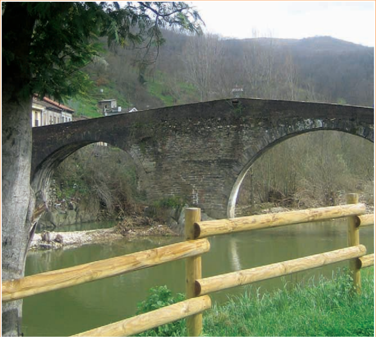
Puente medieval sobre el río Nalón en Laviana
