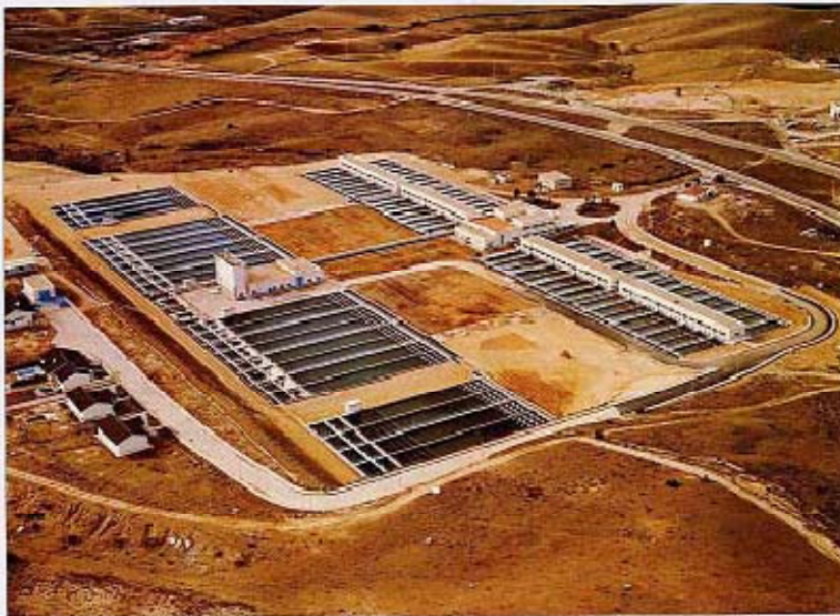
ESTACION DE TRATAMIENTO DE AGUA DE COLMENAR
