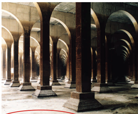
Depósitos de cabecera.
