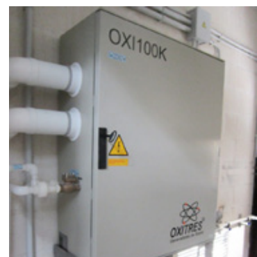
Preoxidación del agua captada por ozonización.
