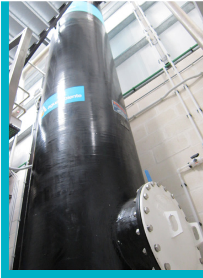
Preoxidación del agua captada por ozonización.
