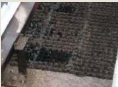
Figura 9. Lodo depositado en las placas del sedimentador.
