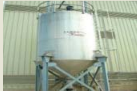
Figura 6. Silo de lodos deshidratados.
