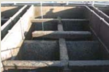
Figura 7. Sección del sedimentador donde se muestran las paredes con lodos adheridos.
