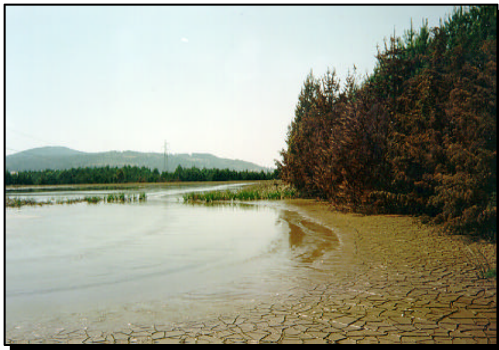
Figura 1. Disposición de lodos en la planta potabilizadora Los Berros
