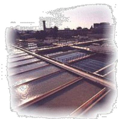
El agua mezclada con el coagulante ingresa en los decantadores permaneciendo 2 horas en estado de semiquietud permitiendo que se realice la aglutinación (gracias a la atracción física) de las partículas de arcilla y bacterias en grandes coágulos que precipitan.
