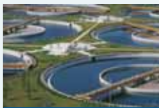
DEPURADORA DE ARAZURI
